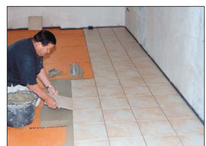
12 Verlegung des Fliesenbelags auf DITRA in Dünnbettmörtel.
