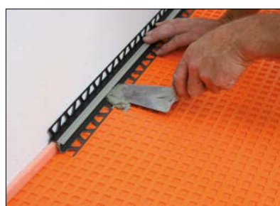
11 Einbau des Randbewegungsfugenprofils Schlüter-DILEX-EK bzw. -DILEX-RF.
