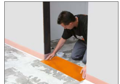
6 Türbereich – Ausgleichsplatte EN FG (glatte Folienplatte) einpassen.
