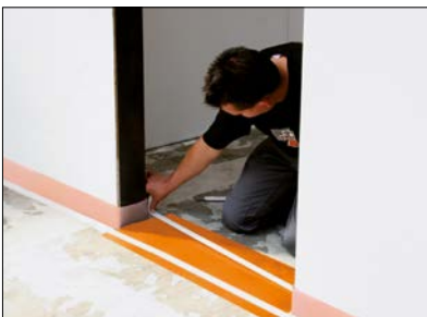
7 Türbereich – beigefügte Doppelklebebänder aufbringen.
