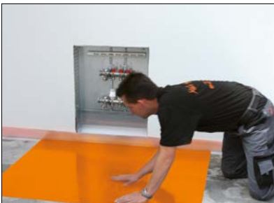
4 Verteilerbereich – Ausgleichsplatte Schlüter-BEKOTEC-EN FG (glatte Folienplatte) einpassen.
